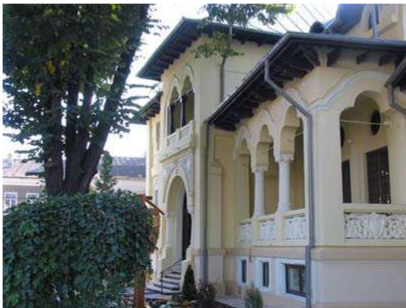
Corpul B al Centrului de plasament nr.5 „Simion Mehedinți”, de pe strada Nicolae Bălcescu nr. 19.
